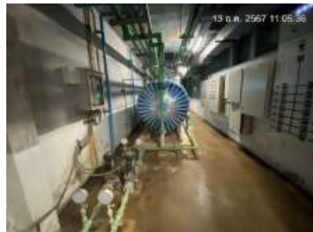
เครื่องทำน้ำร้อนแบบ Heat pump
