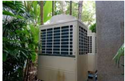
เครื่องปรับอากาศแบบ VRF
